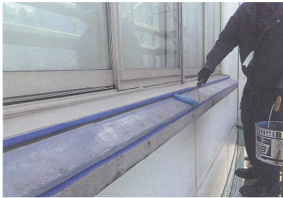
↑庇の防水修繕
