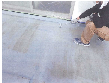
↑2階バルコニー床の塗装
